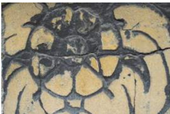
Fissures et craquelures
