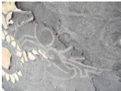
Problème de cohésion et d'adhésion entre les couches avec perte de matière
