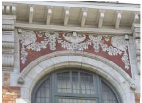
En frise, sous la corniche
