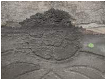
Apparition de croûtes gypseuses
