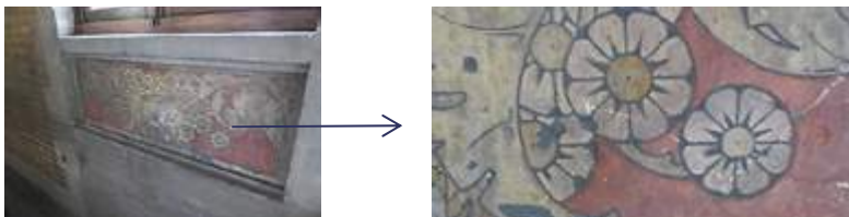
Sgraffite situé à portée de main dans une montée d'escalier
