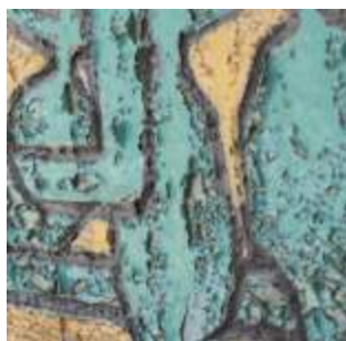
Écaillage d'un surpeint
